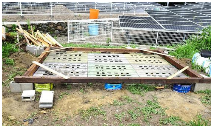
寄せ集めの資材で、なんとか基礎が出来上がった(パレット6、ペール缶にセメント8枠)。 8月下旬、柱が立つ!!(柱は久万高原の杉材) 熱い最中、IN氏に感謝!!
