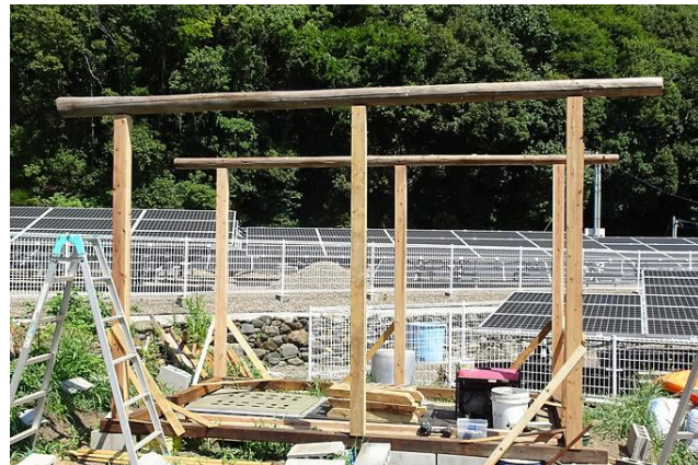
寄せ集めの資材で、なんとか基礎が出来上がった(パレット6、ペール缶にセメント8枠)。 8月下旬、柱が立つ!!(柱は久万高原の杉材) 熱い最中、IN氏に感謝!!
